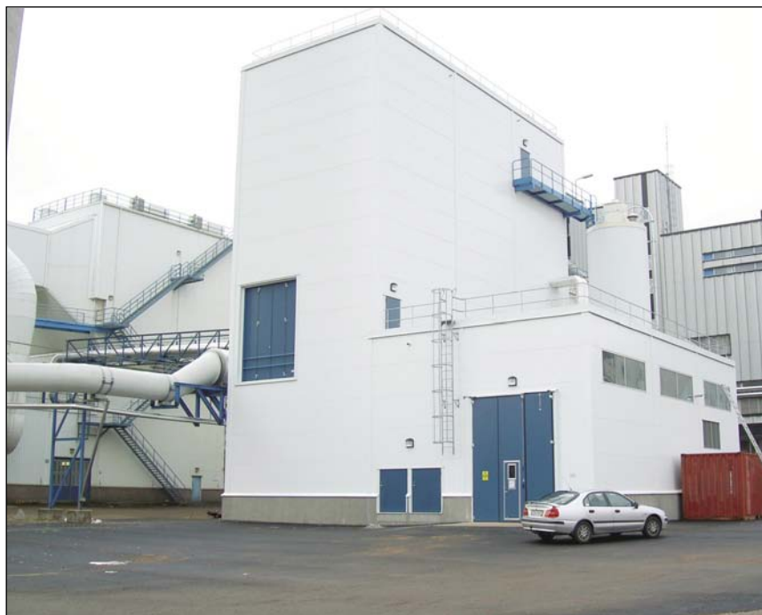
Kompletteringen av Hedenverket har inneburit att en helt ny byggnad rests.
