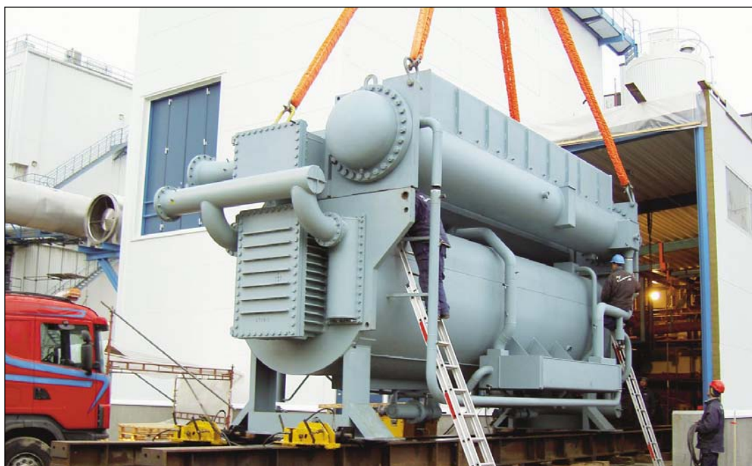
Inlyft av absorptionsvärmepumpen. Med hjälp av den kommer extra energi utvinnas till fjärrvärmenätet.
