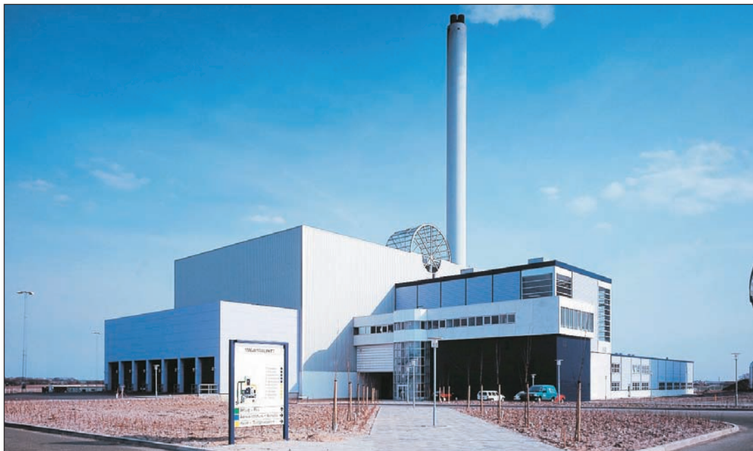
Ett genombrott för Adiox är uppgraderingen av rökgasreningen vid Måbjerkværket i Danmark.
