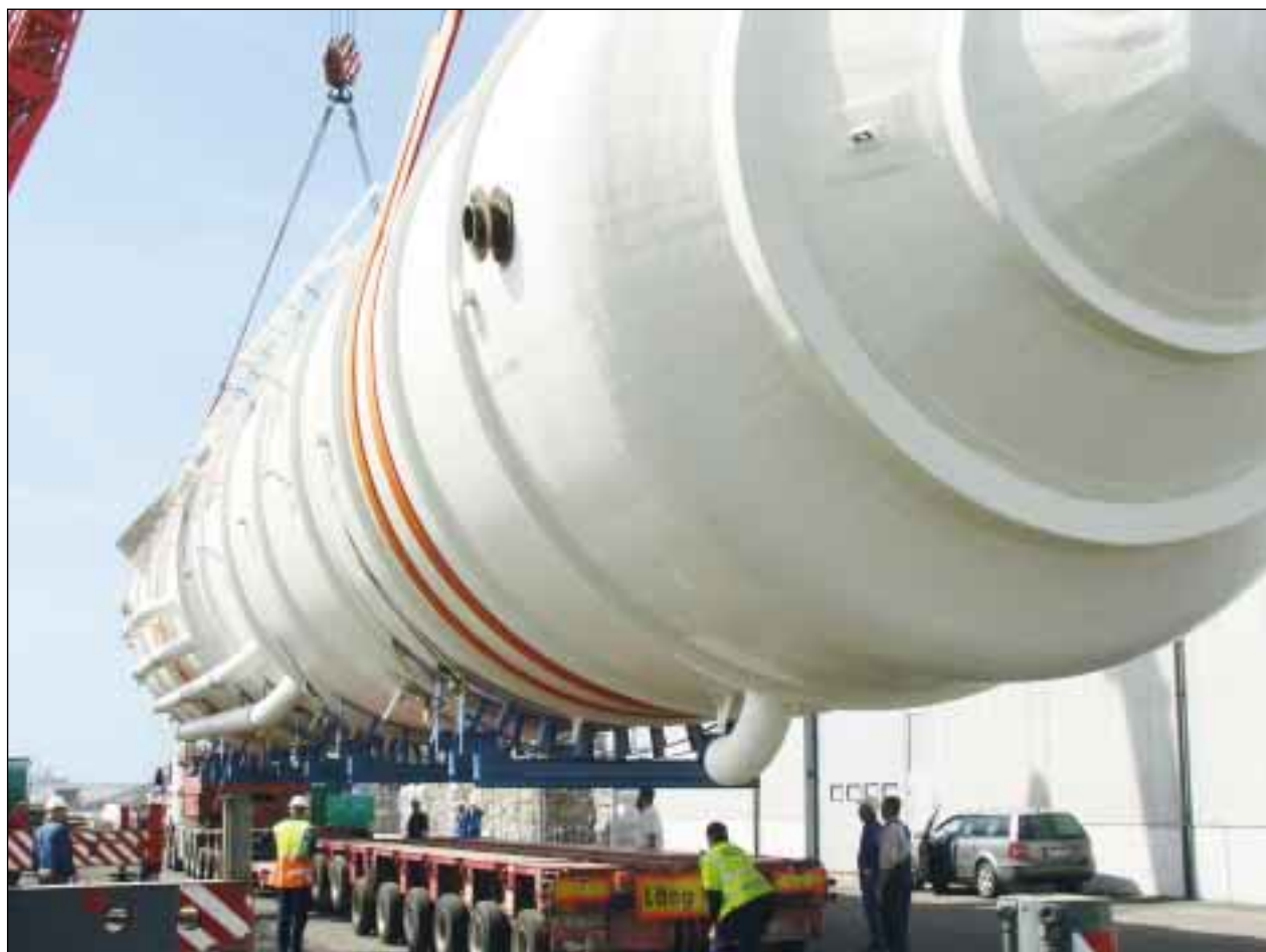
Den nya skrubbern anländer till Sysav. Många av komponenterna i skrubbern monterades redan under tillverkningen.
