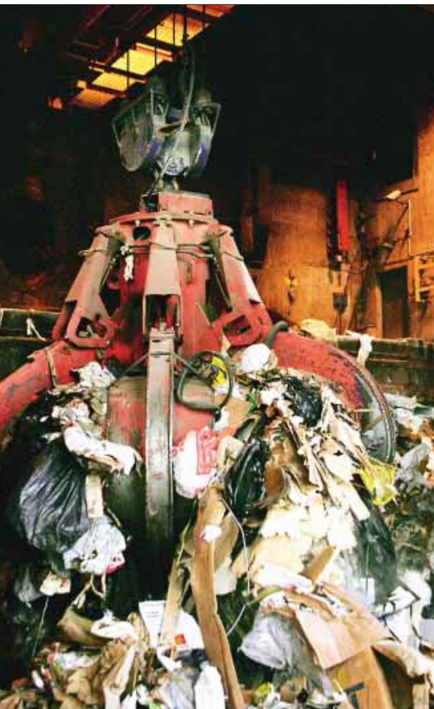
I och med att avfallsmängderna fortsätter att öka planerar nu Sysav att bygga ut avfallsförbränningen med ytterligare en linje.
