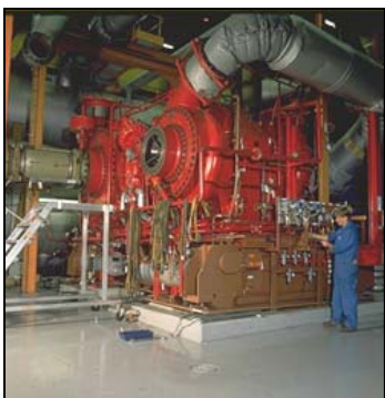
Service vid värmepump-anläggning, Rya, Göteborg
